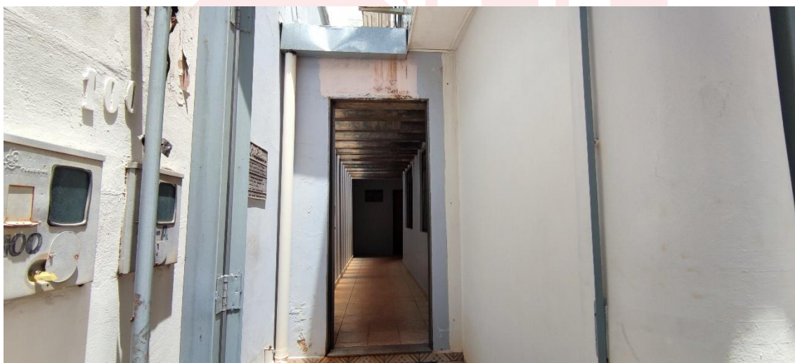
Figura 2 - Entrada da Câmara municipal de Arapuá - MG
