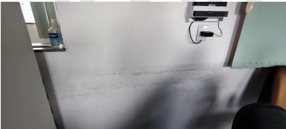
Figura 18 - Local que receberá pontos elétricos
