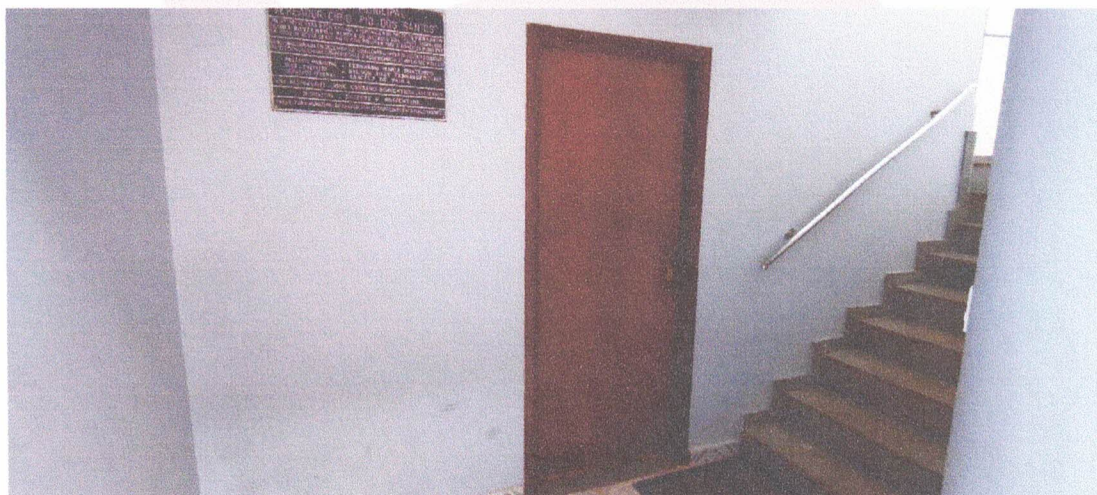
Figura 7 - Porta de prancheta - Local (Pé da escada)
