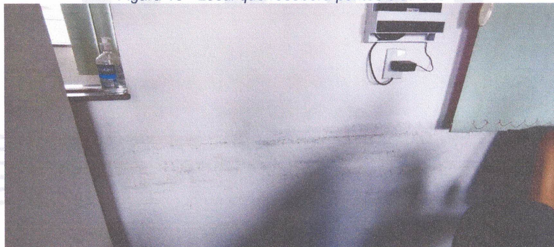
Figura 18 - Local que receberá pontos elétricos
