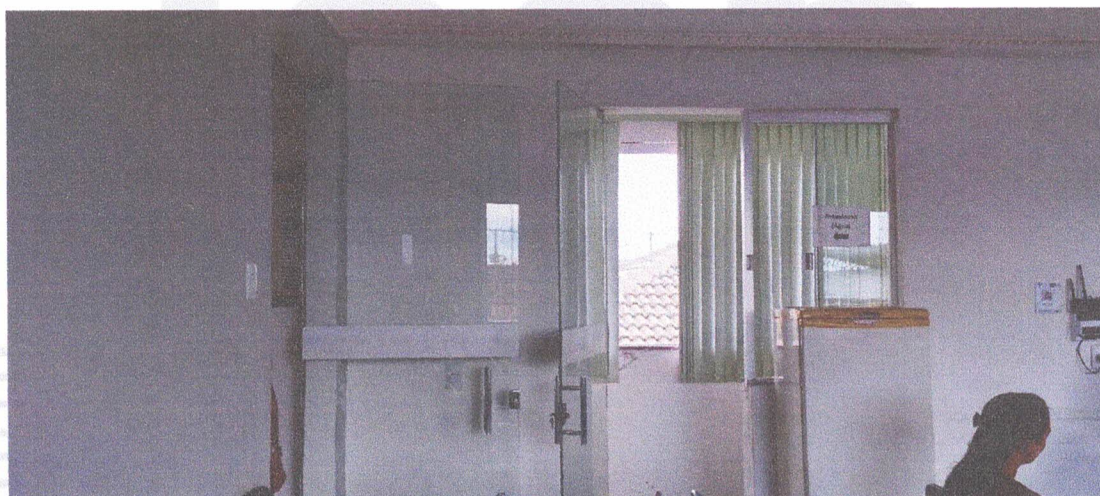
Figura 13 - Porta de acesso a cozinha.
