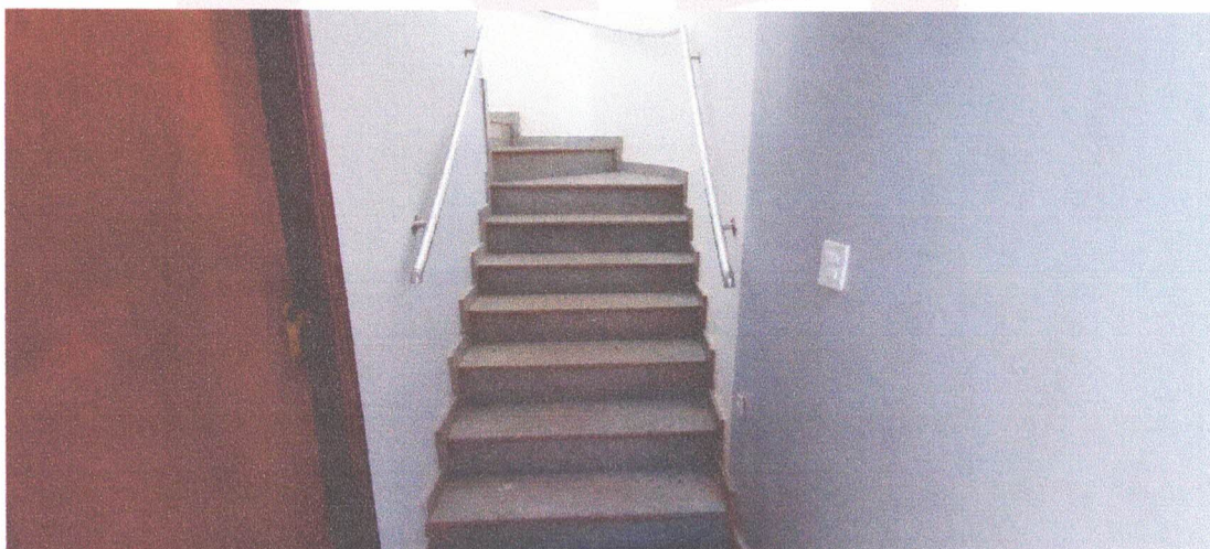
Figura 10 - Escada em Granito
