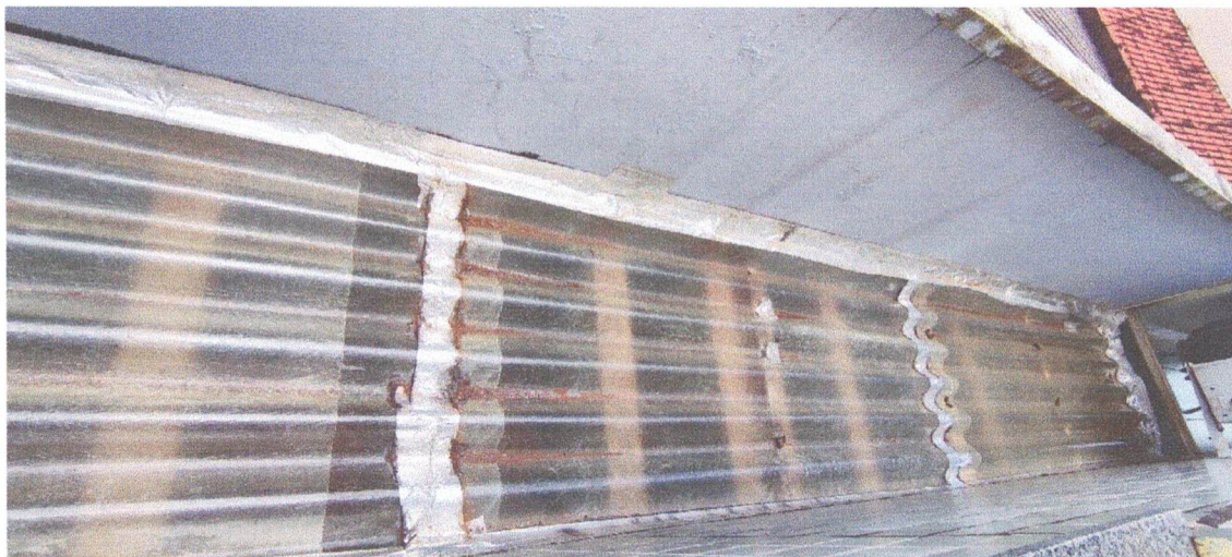
Figura 16 - Telhas plásticas transparentes
