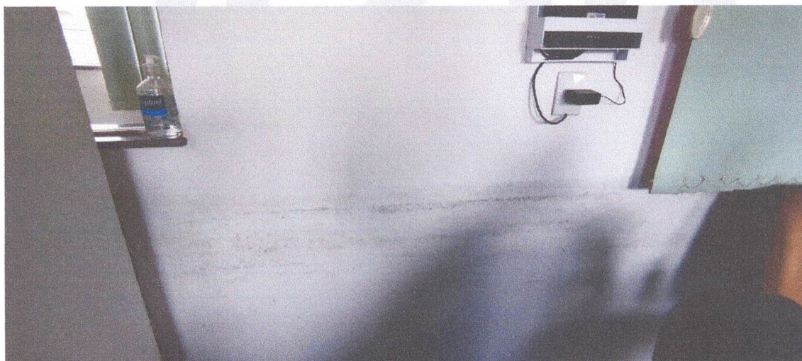
Figura 18 - Local que receberá pontos elétricos
