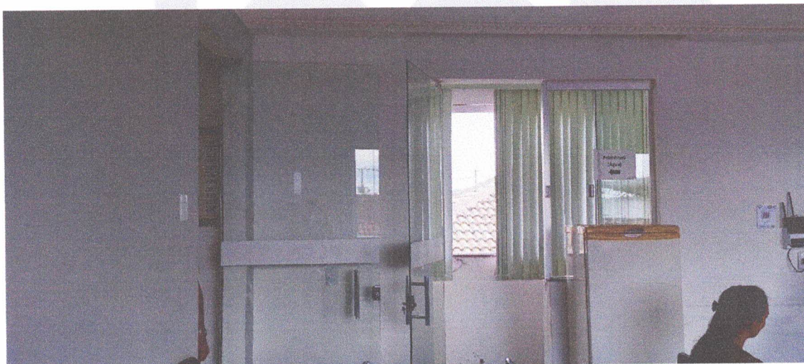
Figura 13 - Porta de acesso a cozinha.
