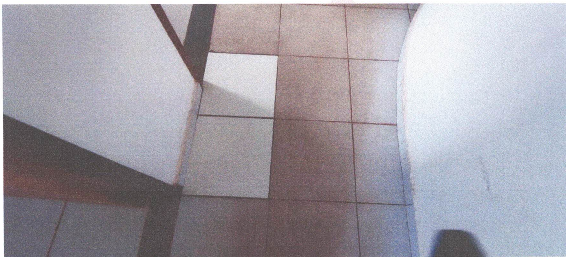
Figura 6 - Cerâmica na área de circulação
