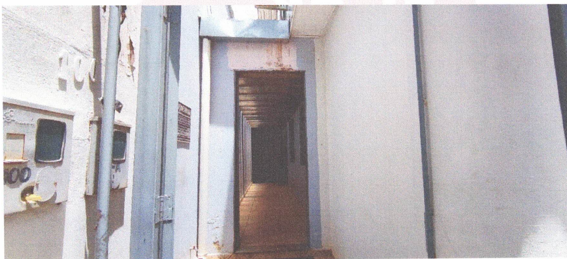
Figura 2 - Entrada da Câmara municipal de Arapuá - MG
